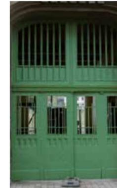
Das Eingangsportal der ehemaligen Wellner-Werke (ABS), ein großes zweiflügeliges, mit Jugendstilelementen verziertes Eisentor, welches im Laufe der Jahre mit mehreren Farbschichten überzogen wurde, die teilweise nur noch den Rost zusammenhielten, wurde im September 2020 ausgebaut und von der Firma Metallbau Mehlhorn (Gelände Blema) denkmalgerecht instandgesetzt.
